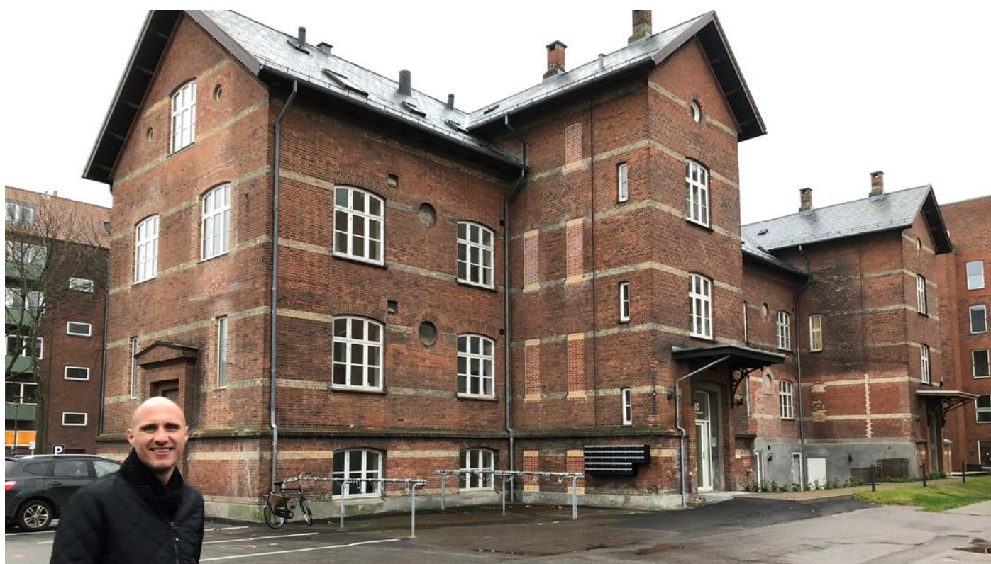
Projektleder Morten Meldgaard foran det gamle kasernehospital.
