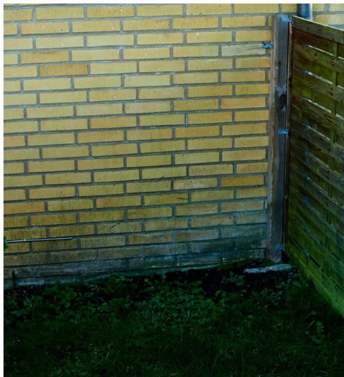
Hvor der er opstigende fugt dannes der kuldebroer, og i værste fald kan der komme skimmelsvamp.
