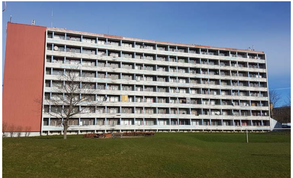
Højhuset på Astridsvej i Skovgårdsparken skal gennemgå en såkaldt sokkelrenovering.
